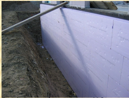
Perimeterdämmung KG
