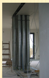
Lüftungsverteilung in abgehängter Decke
