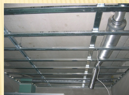
Lüftungsverteilung in abgehängter Decke
