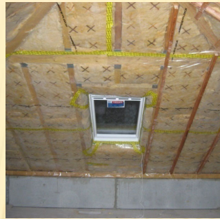
Vollsparren- dämmung und Dampfbremse
