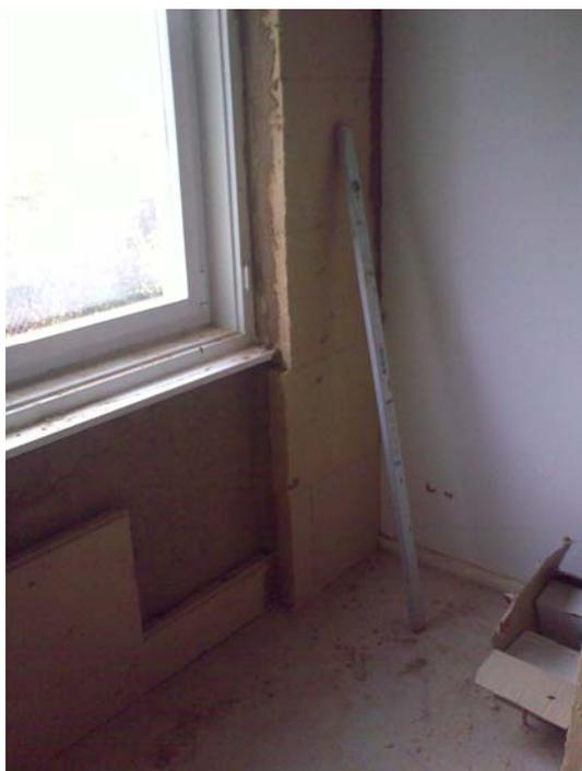
Dünnere Dämmschicht von innen auf allen Außenwänden möglich.
