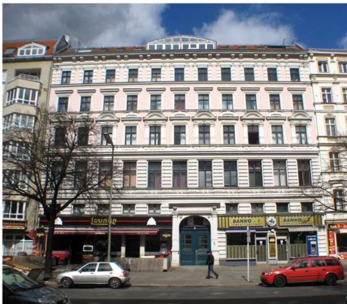
Normale Dämmschicht von außen auf allen Außenwänden möglich außer Straßenfassade
