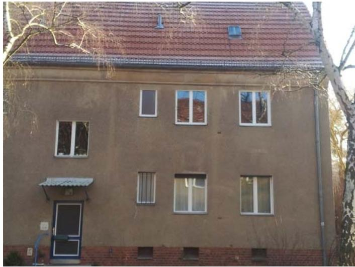
Dünnere Dämmschicht von außen (Dämmputz) ggf. auf allen Außenwänden möglich.
