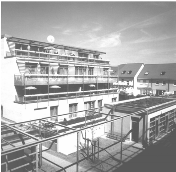
Abb. 4: Blicke auf Gebäude A
