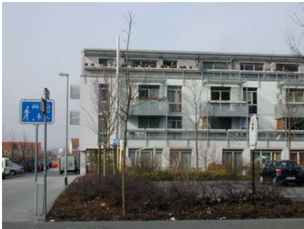
Abb. 3: Blicke auf das Gebäude B
