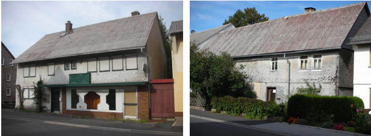
Abb. 22: Leerstehende Fachwerkhäuser in der Marktstraße
