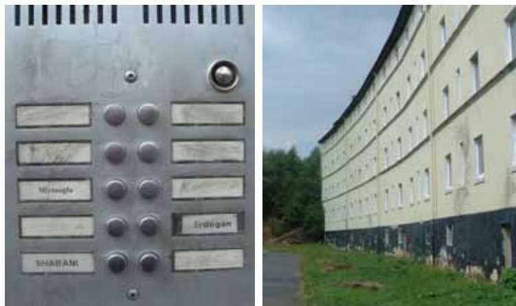
Abb. 2-3: Zunehmende Leerstände in nicht mehr marktfähigen Objekten treten auch in entspannten Wohnungsmärkten in Hessen auf. Eindrücke aus der Fichter- / Oestmann-Siedlung in Kassel. Bildquelle: IWU.
