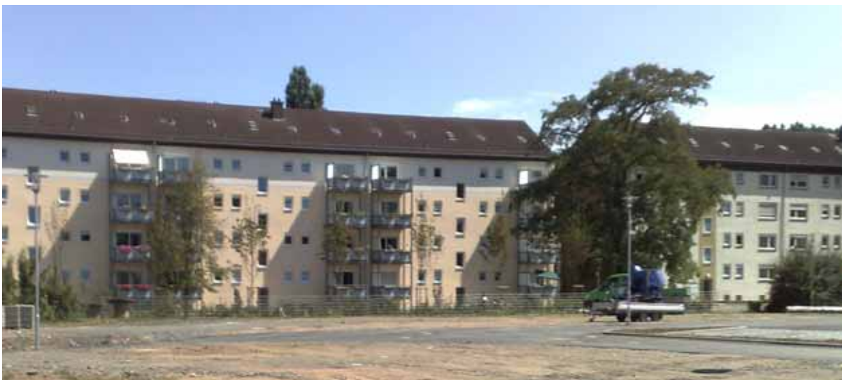
Abb. 2-1: Energetische Modernisierung, Verlegung von Hauseingängen und Anbau von Balkonen in Wetzlar. Die ARGE zahlt auch die um 1 €/m 2 erhöhten Mieten. Bildquelle: IWU.
